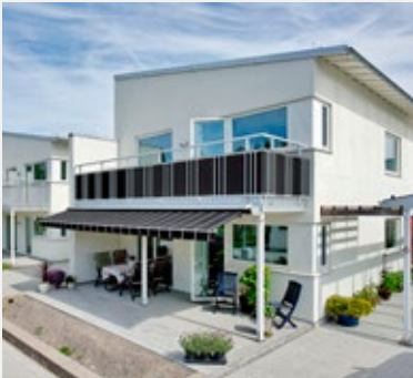
Moderna radhus med putsade fasader i området Nyby Gärde i Falkenberg.
